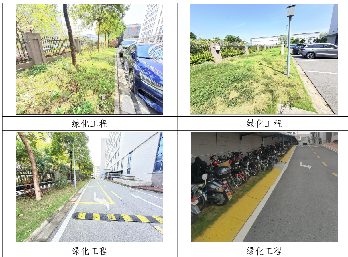
图 3-3 项目区植物措施完成情况
